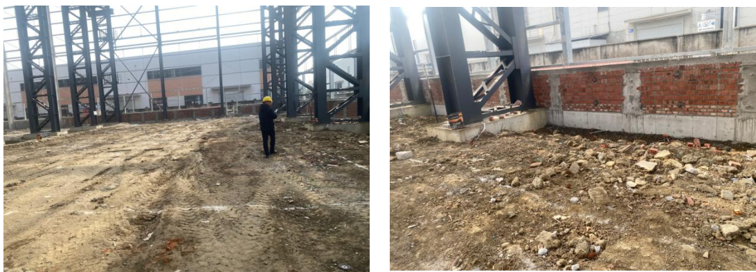
探伤室拟建位置
